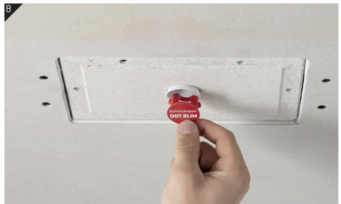
5. Schrauben Sie das Modul von unten durch die Fixierungslaschen an die Decke. Dabei kann die Einbauhilfe nützlich sein, um das Modul an der Unterkante der Decke zu halten. Screw module unto ceiling from below through mounting flaps. The mounting aid included in the delivery may be helpful for keeping the module flush with the ceiling's lower edge.
